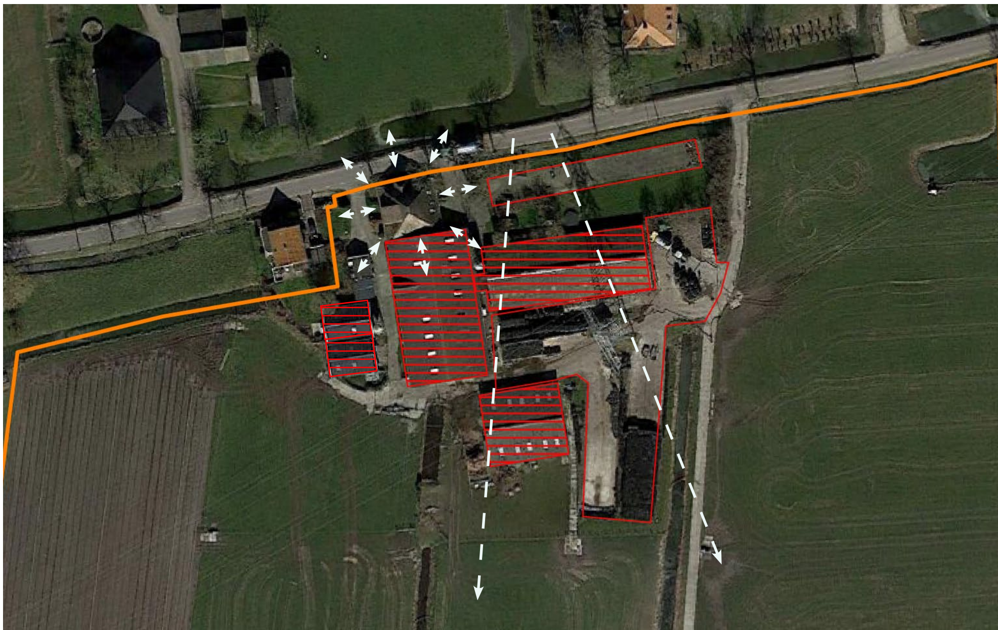
Te saneren Bobeldijk 110, Berkhout
