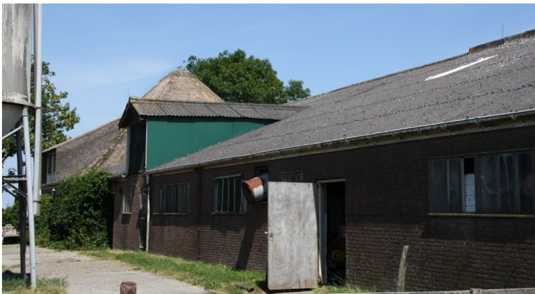
Stal ca. 820 m2 is gebouwd tegen de karakteristieke stolpboerderij aan. Het dak is van (asbesthoudend) plaatmateriaal.
