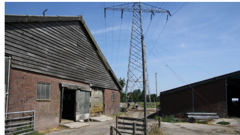
Stal ca. 380 m2 is rechts in beeld, stal ca. 820 m2 is links in beeld. De hoogspanningskabels gaan er tussendoor en overheen.
