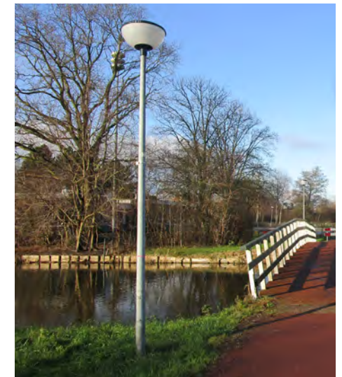
armatuur fietspad (innolumus ariane)
