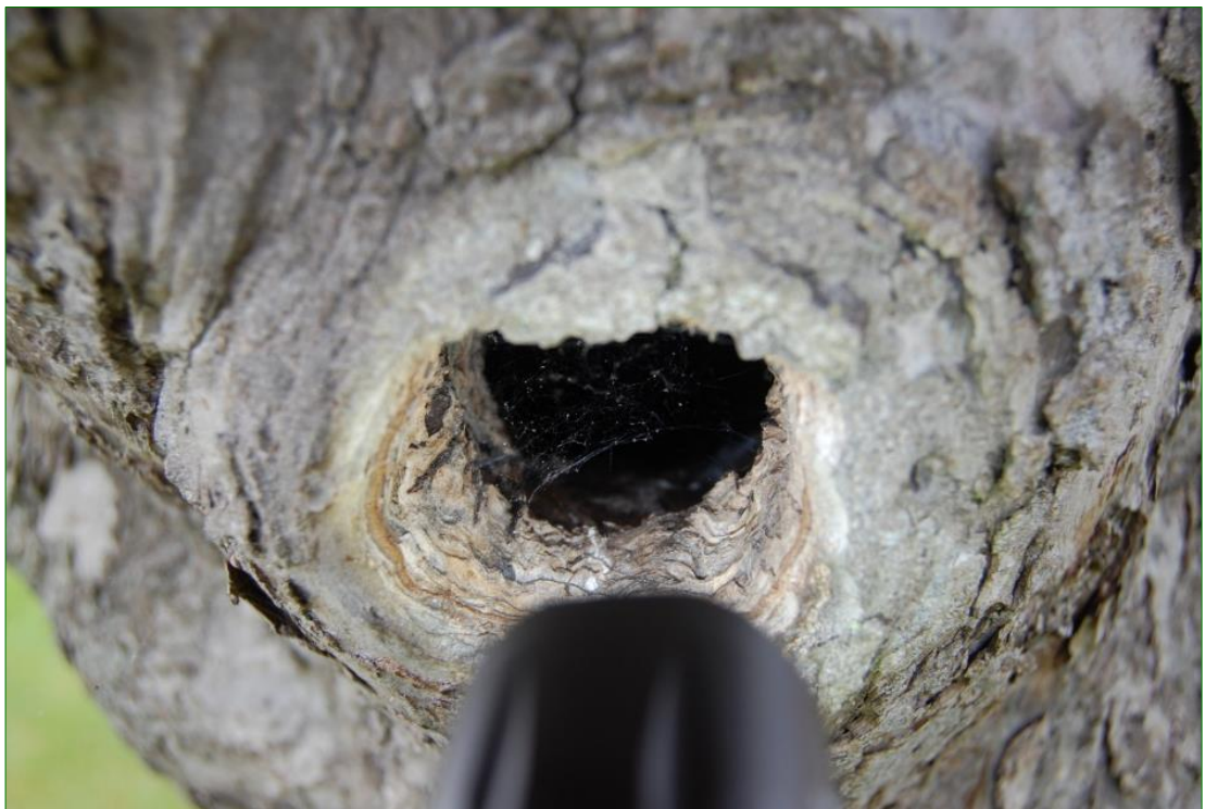
Inspectie aanwezige holtes.
