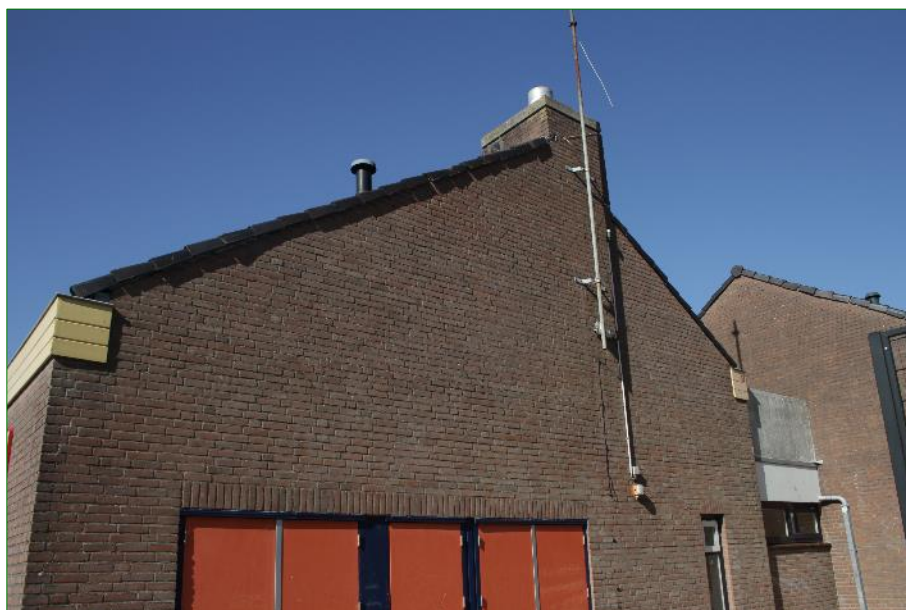
Aanzicht van een kopse kant van de bebouwing met een met dakpannen belegd dak.
