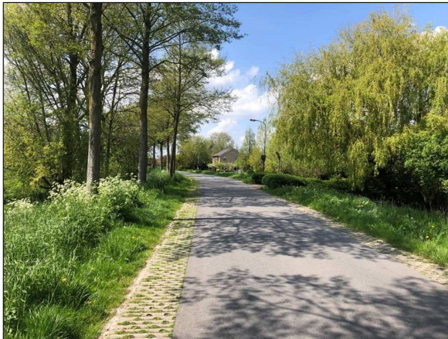
Figuur B1.6: Julianaweg ter hoogte van perceel 2a
