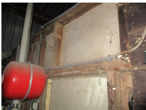
Zachtboardbeplating boven verwarmingstoestel
