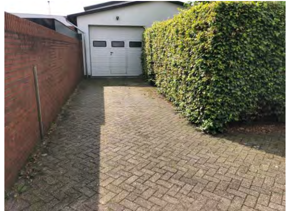
Figuur 9: Dak(goot) bebouwing
