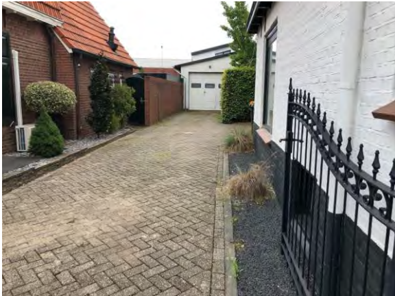
Figuur 8: Overzichtsfoto bebouwing
