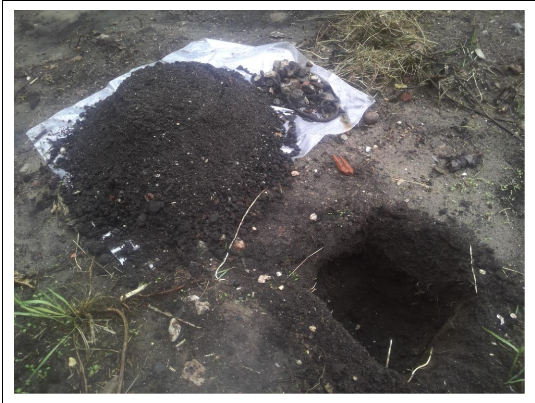
Foto 13. Asbestgat en opgegraven materiaal ASB-11
