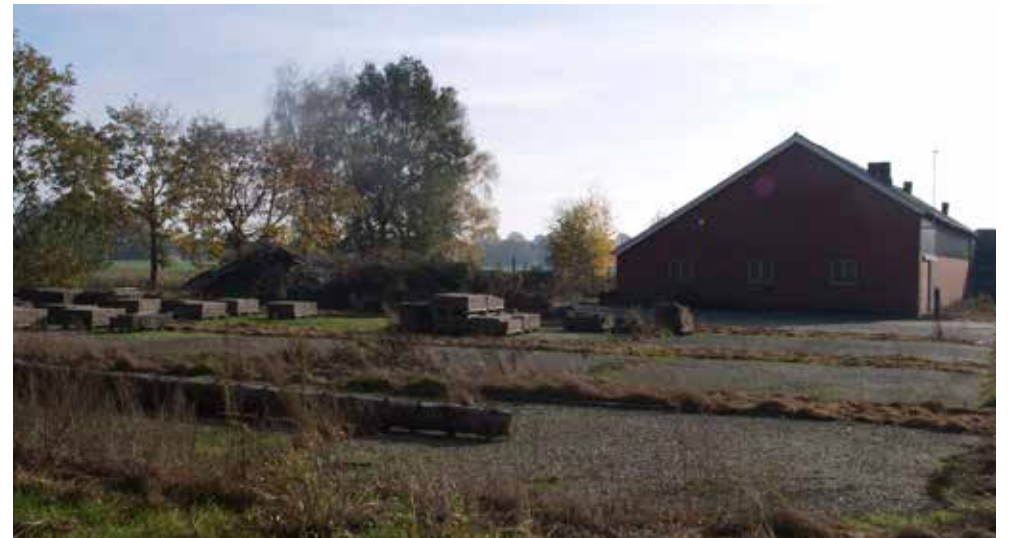
Afbeelding: Te slopen bebouwing.
