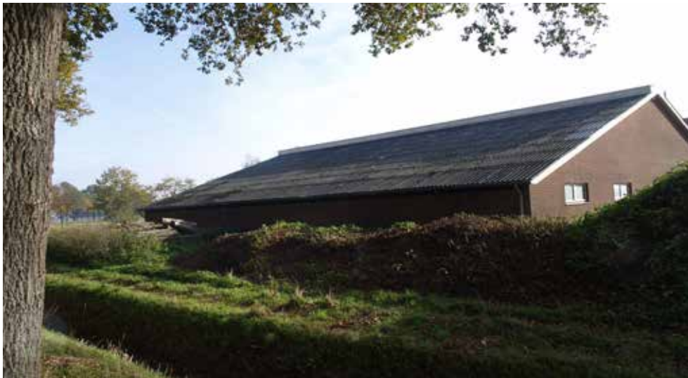
Afbeelding: Te slopen bebouwing.
