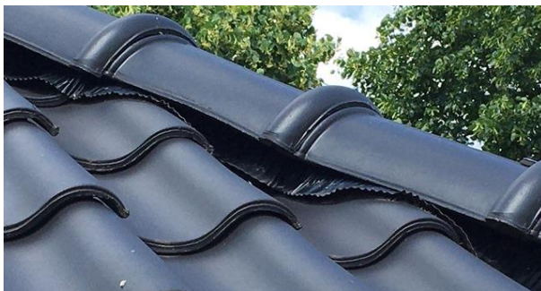
Door het aanbrengen van folie kunnen vleermuizen niet onder de dakpannen kruipen via nokvorsten.
