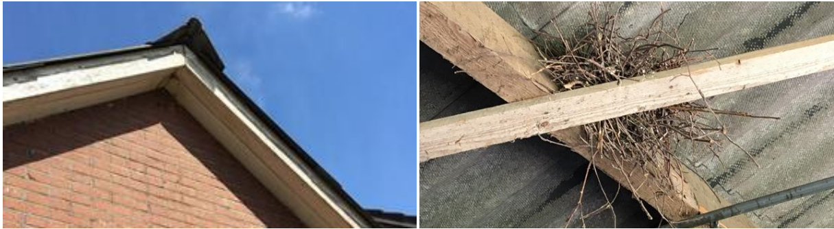
Foto links: restanten van een oud nest van de huiswaluw aan één van de te slopen stallen. Foto rechts: nest van de houtduif in een kapschuur.
