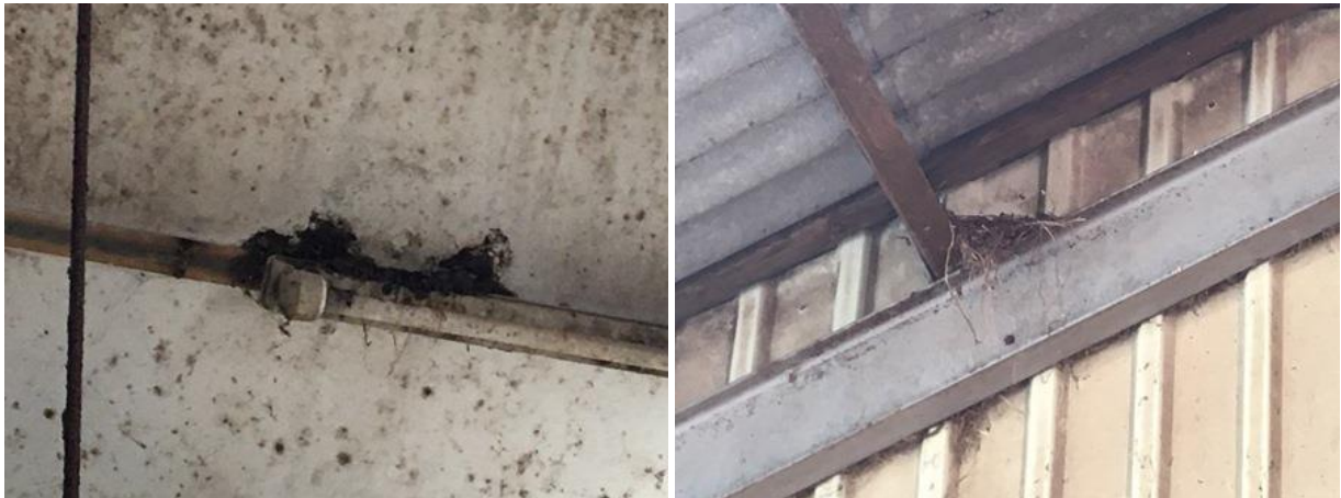
Oude vogelnesten in de te slopen gebouwen.
