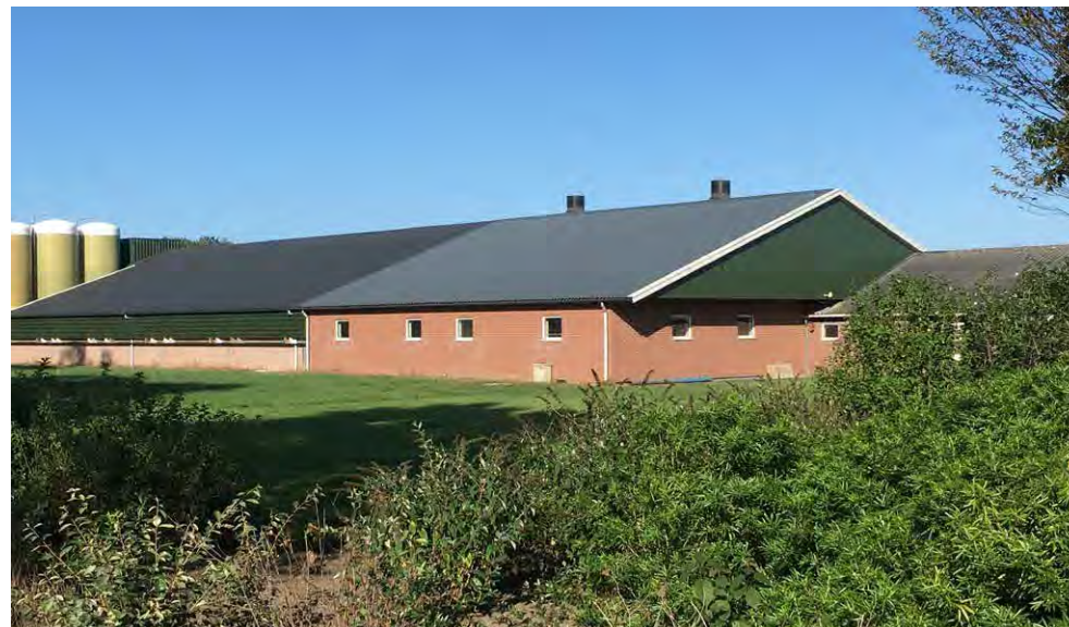
Afbeelding: stallen aan de kranenkampsweg, locatie 2e bedrijfswoning.
