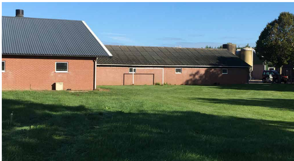
Afbeelding: stallen aan de kranenkampsweg, locatie 2e bedrijfswoning.
