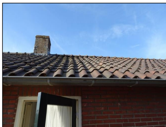
Figuur 10. De dakgoot die geschikt is als nestlocatie voor huismussen.
