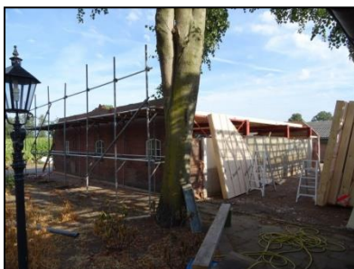
Figuur 6. Voormalige koeienschuur waar het dak al af is en weer opgebouwd wordt.
