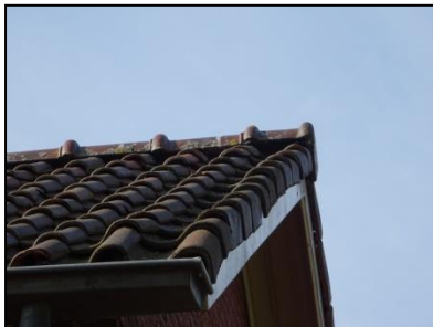
Figuur 11. Het zadeldak met gevelpannen met geschikte openingen die toegang bieden tot verblijfplaatsen van vleermuizen.
