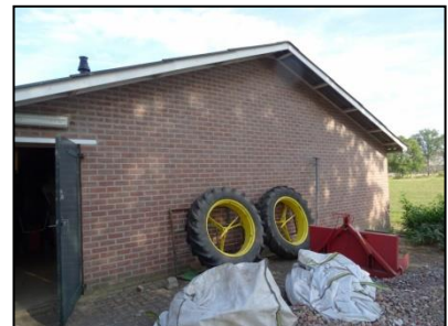
Figuur 5. Oude varkensschuur die gerenoveerd zal worden.
