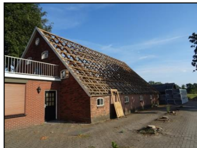
Figuur 4. Reeds gesaneerde schuur.
