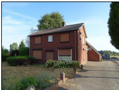
Figuur 3. Het vooraanzicht van het te slopen woonhuis.
