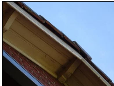
Figuur 12. Kantpannen die toegang bieden tot de onderzijde van het dak dat gebruikt kan worden als verblijfplaats van vleermuizen.
