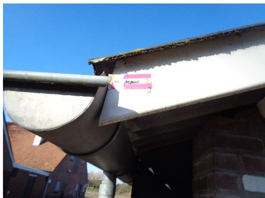
Monsternamelocatie MA05 (asbest niet aantoonbaar)
