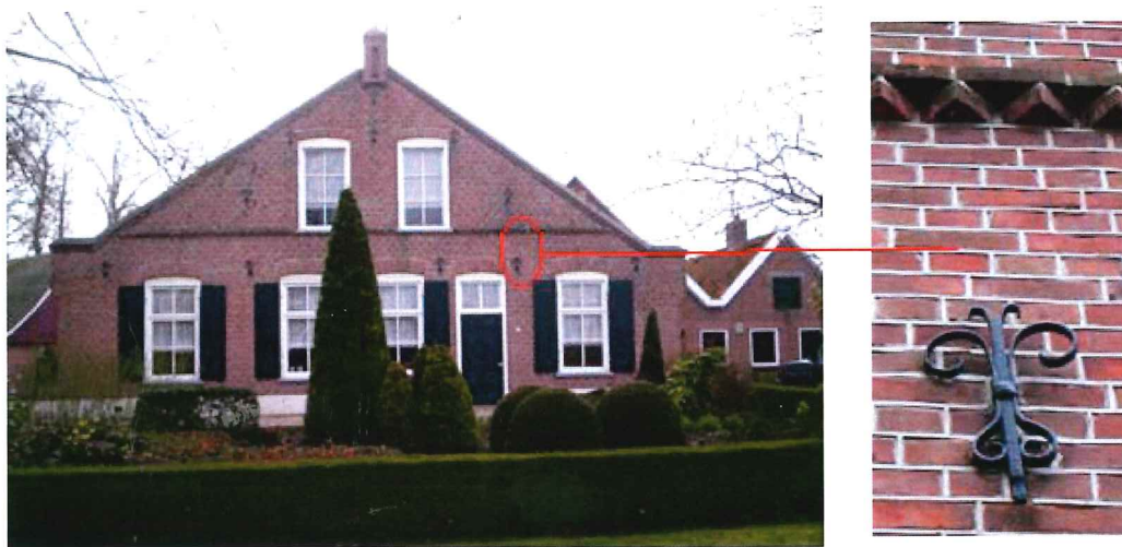
Afb. 7: Voorgevel met detail van een muuranker en zaagtand
