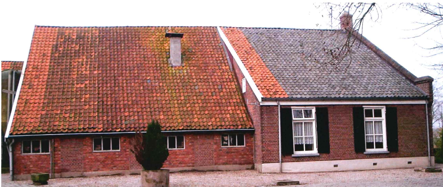
Afb. 14: Oostgevel B en C
