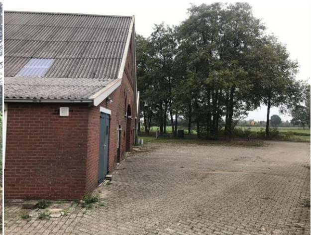
Figuur 9: Dakgoot met afvoer
