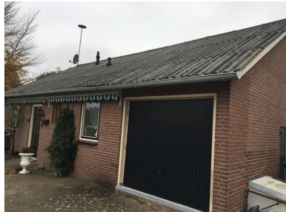
Figuur 12: Dak(goot) bebouwing
