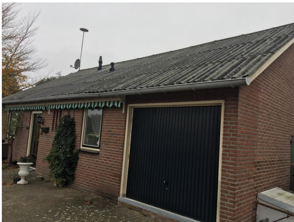
Overzichtsfoto bebauwing met dakgoten
