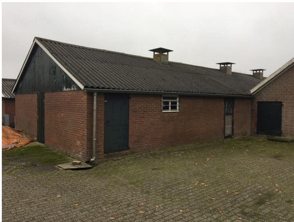
Overzichtsfoto bebauwing met dakgoten
