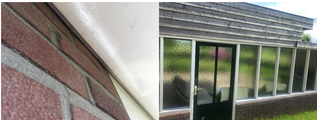
Foto links; de betimmering van het dak overstek sluit naadloos aan op de buitengevels. Foto rechts; de planken sluiten strak op elkaar aan.
