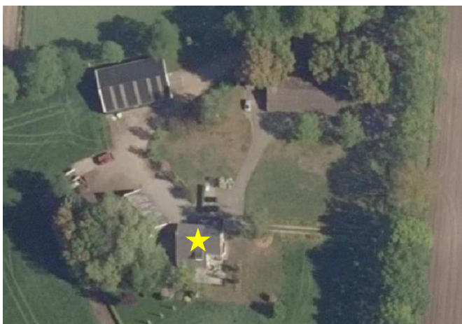
Detailfoto van het erf. De te splitsen woning, wordt met de gele ster aangeduid.
