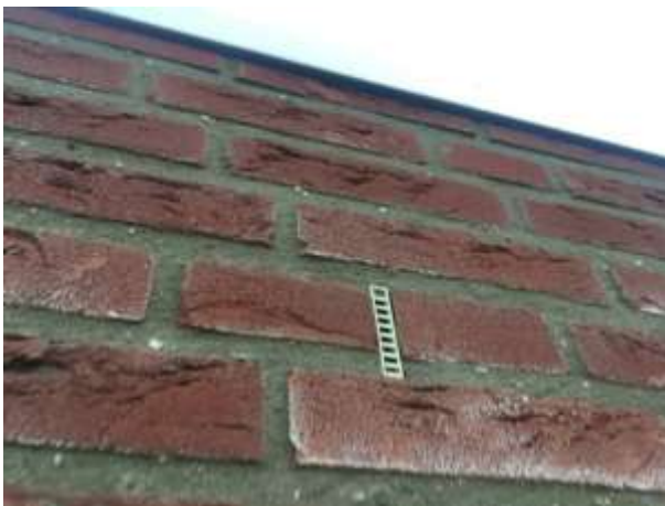
De aanwezige bijenbekjes bedekken de stootvoegen in de buitengevel van de schuur net naast het plangebied.
