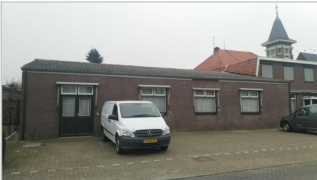
Zuidwestgevel van het zaaltje gezien vanuit het zuiden. Foto:
