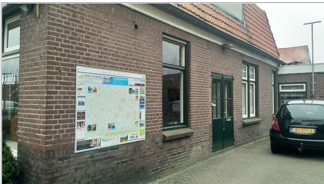
Noordoostgevel van Waalderweg 2 gezien vanuit het noorden. In de buitenmuur zijn openingen aanwezig waar kabels en een oude afvoerbuys de buitenmuur verlaten welke in gebruik kunnen worden genomen door gebouwbewonende vleermuizen. Foto: / Ecoresult B.V.
