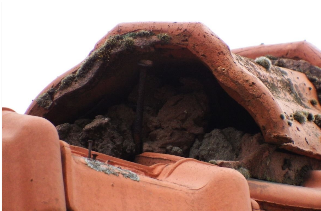
Detail van de onderzijde van de nokpannen. Er zijn openingen aanwezig welke geschikt zijn als verblijfplaats voor huismus en gierzwaluw. Foto: | Ecoresult B.V.
