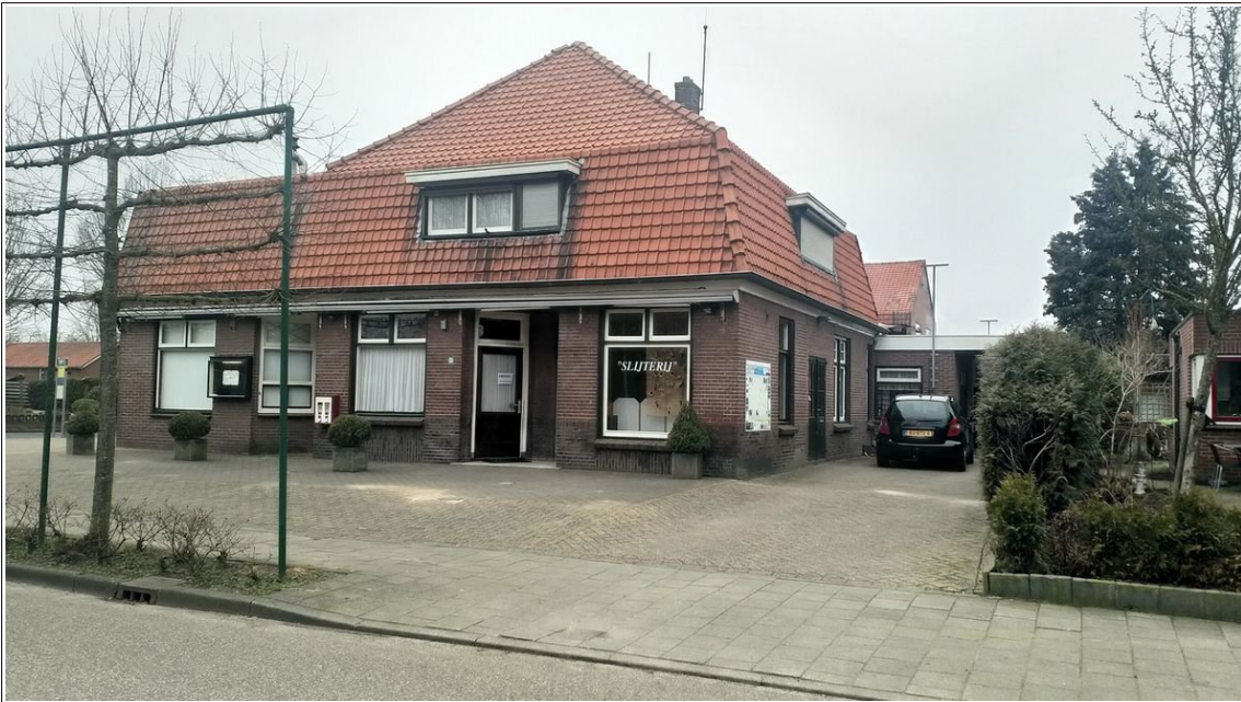
Afbeelding 3: Waalderweg 2, gezien vanuit het zuidoosten. Foto:
