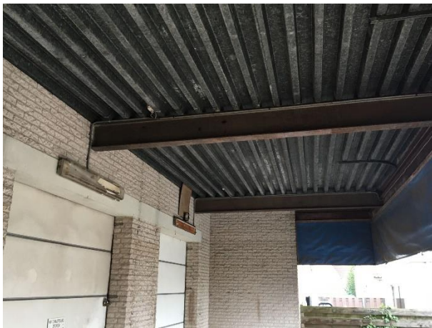
Het metalen afdak sluit strak aan op de ondersteunende balken waardoor er geen nestlocaties voor vogels ontstaat.
