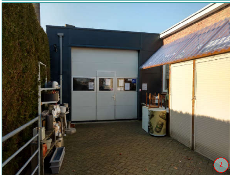
Aanbouw aan het stenen gebouw bestaande uit gevelpanelen.
