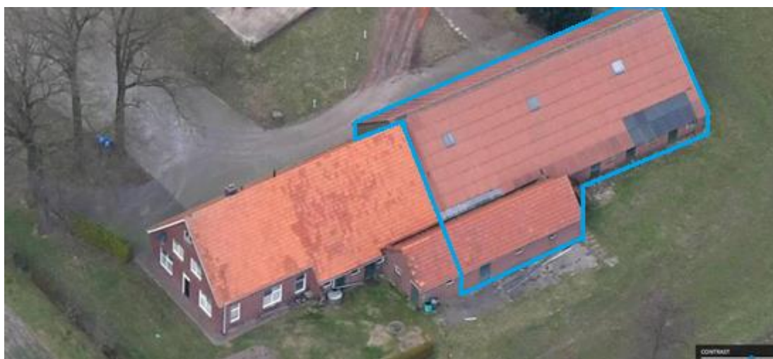
Afbeelding 2.3: luchtfoto uit 2018 met daarop de oude schuur (blauw gearceerd), welke in 2019 is gesloopt
