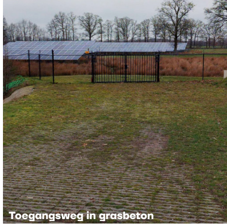
Toegangsweg in grasbeton
