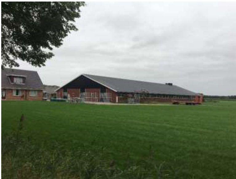
Zicht op het erf vanaf de Oude Aaltenseweg, in noordoostelijke richting, op het plangebied.
