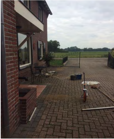
Figuur 8: Overzichtsfoto bebouwing
