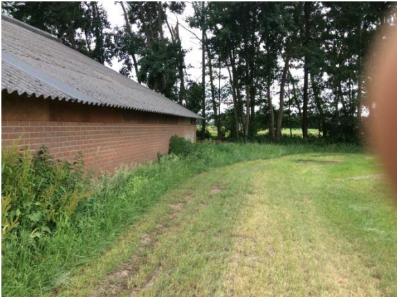
Figuur 8: Overzichtsfoto bebouwing
