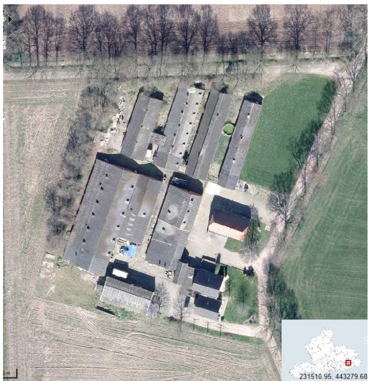
Detailopname van het erf. (foto: Provincie Gelderland).
