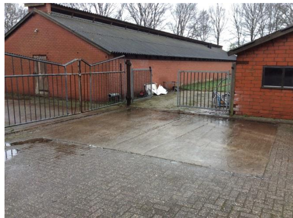
Figuur 11: Overzichtsfoto bebouwing
