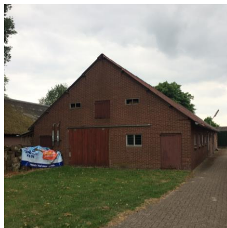
Figuur 4 Foto schuur 30a
