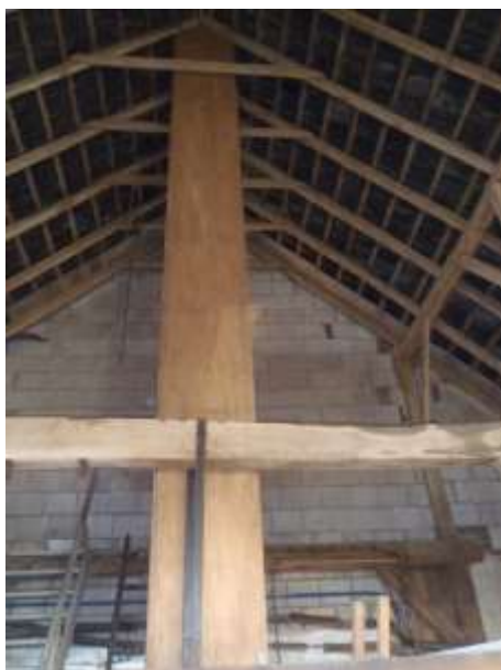
Foto 3: binnenzijde met het eikengebint en het niet beschoten pannendak. Midden op de foto is de ventilatieschacht zichtbaar. Op de achterzijde de massieve kalkzandstenen brandmuur
