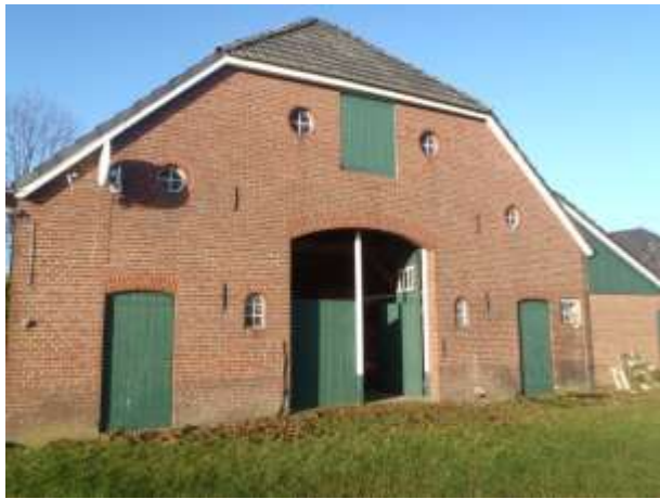
Foto 1: Achterhuis aan de buitenzijde. De windveer sluit nauw aan bij het metselwerk en onder de vorsten zijn vogelschroten aanwezig.
