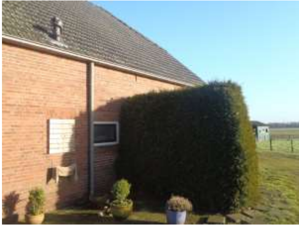
Foto 7: het voorhuis met het afgeschermd toiletraam met daarachter het raam van de badkamer. Het dak van het voor en achterhuis loopt in elkaar over.
