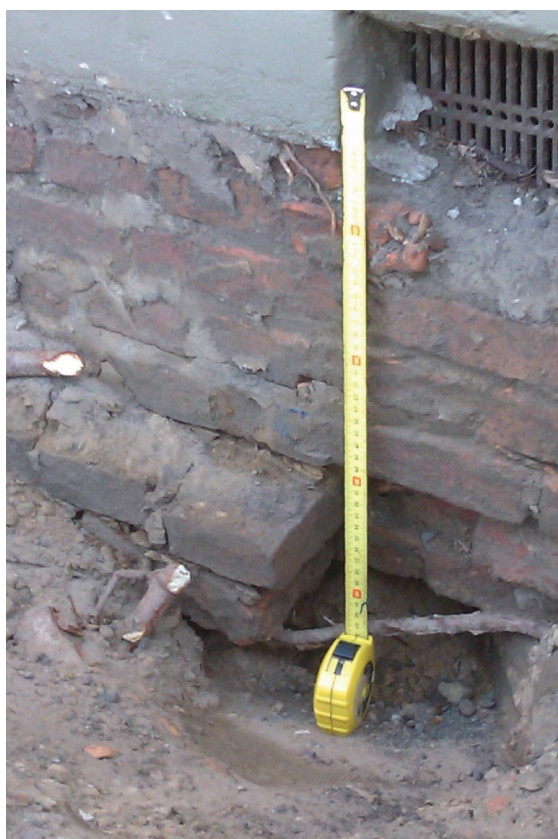
Foto 1: fundering onder linker gevel
