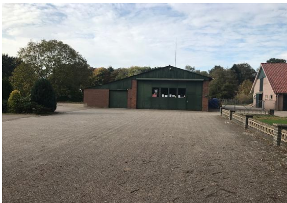
Figuur 8: Overzichtsfoto bebouwing
