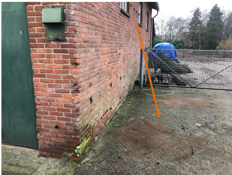
Figuur 2: Ondergrondse opslagtank 3.000l
