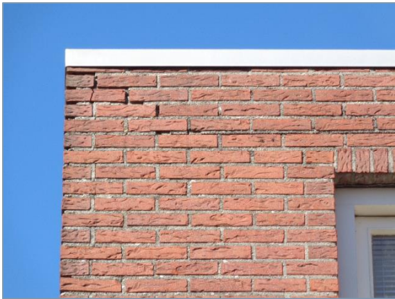
Foto 5. Detail rand bedrijfspand (zijde Koemstraat) met open stootvoeg en kieren (langs dakrand).
