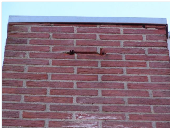
Foto 8. Detail winkelpand Dijkstraat 14 met ruimte onder dakrand en open (stoot)voeg.
