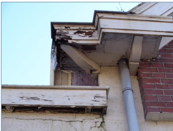
Foto 7. Detail winkelpand Dijkstraat 16 met ruimte onder dakrand.
