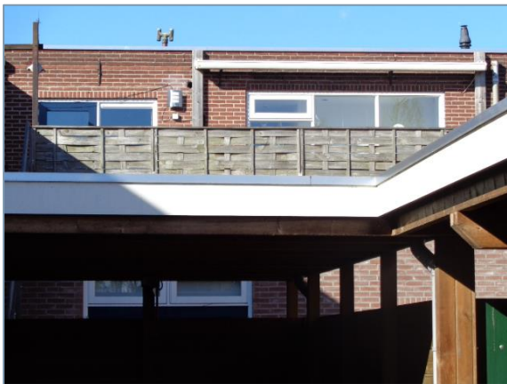
Foto 3. Achterzijde winkelpanden 14-16 met bovenwoningen (zijde Koemstraat). Een pannendak ontbreekt hier en er zijn geen geschikte ruimten aanwezig langs de dakrand en bij de regenpijp voor gierzwaluw en huismus.
