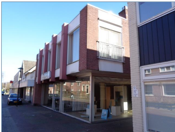
Foto 4. Voorzijde winkelpand Dijkstraat 14. Geschikte kieren, spleten en gaten, voor gierzwaluw en huismus, ontbreken hier.
