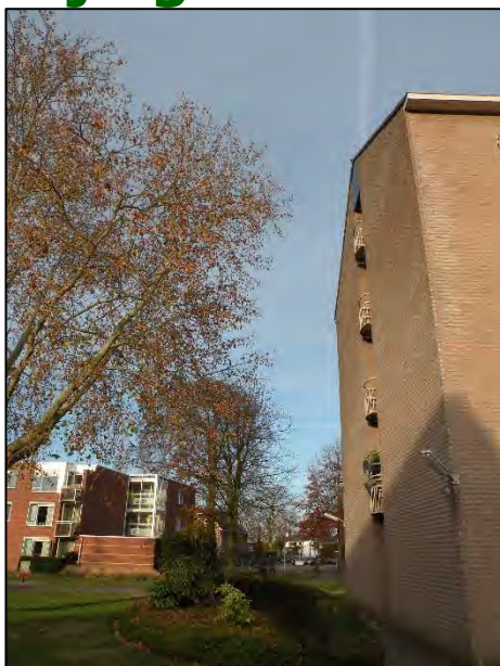
Boom 13: nabij gebouw
