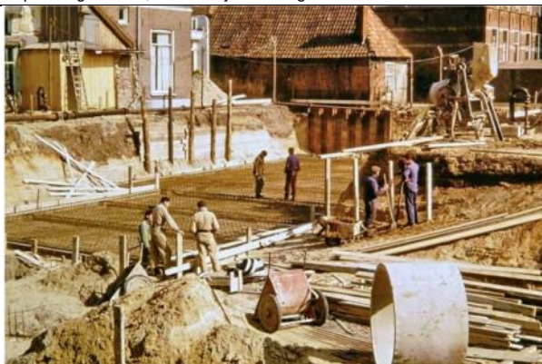
Bouwput Antoniushove 1964. Bovenlangs op de foto het restant van het historisch bebouwingslint en het klooster. In de wand van de schuur middenachter op de foto (schuur achter De Gaper) is historische nog de vakwerkconstructie (vakken gevuld met baksteen) zichtbaar.
