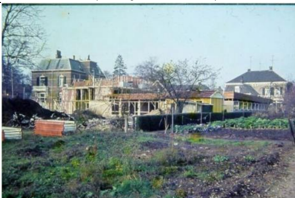
Bouw van de Antoniushove in 1964. Links op de achtergrond de villa Van Basten Batenburg, rechts daarvan een deel van het historisch bebouwingslint met de voormalige woning van Van Batenburg (later garage Langwerden en kazerne vrijwillige brandweer tot de sloop in 1963) en het huis van Dr. Besselink (rechtsachter).
