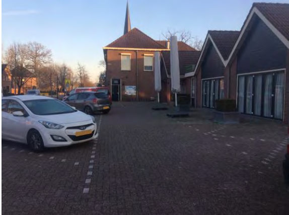
Figuur 8: Overzichtsfoto bebouwing
