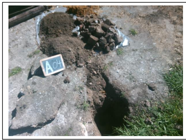
Foto: Inspectiegat A04
