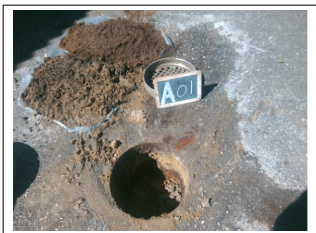
Foto: Inspectiegat A01
