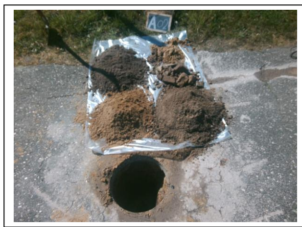
Foto: Inspectiegat A02
