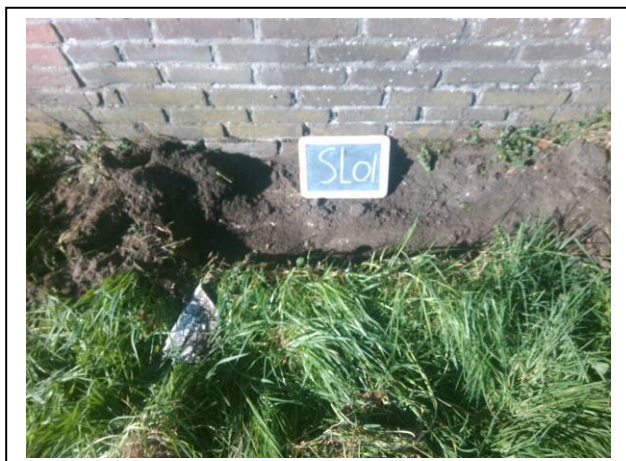
Foto: Inspectiesleuf SL01
