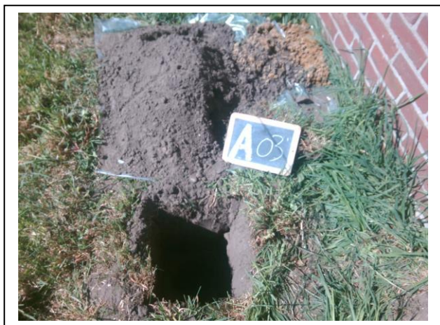
Foto: Inspectiegat A03
