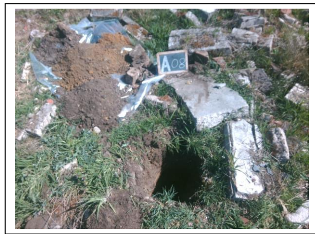
Foto: Inspectiegat A08
