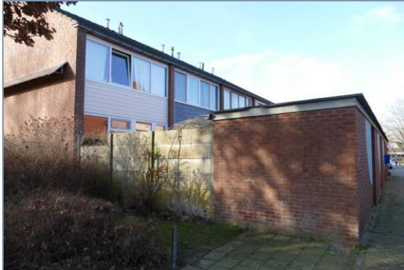
Foto 1. Woonhuizen aan de Hartebroekseweg met een pannendak, waar gierzwaluw en huismus geschikte nestlocaties vinden in de ruimte tussen de dakpannen en het dakbeschoot.
