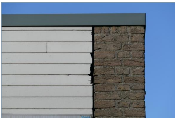
Foto 3. Potentiele locatie paarverblijfplaats in zuidgevel schoolgebouw: kieren tussen muur en gevelbekleding.
