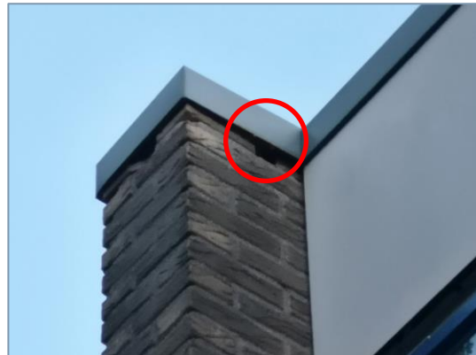
Foto 2. Oostgevel gymzaal met in- en uitvliegplek zomerverblijfplaats (rode cirkel).
