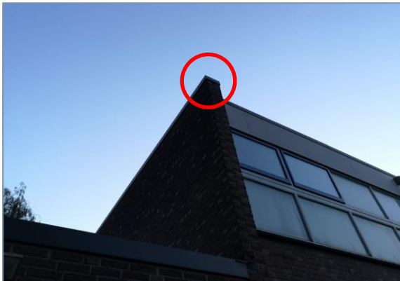
Foto 1. Oostgevel gymzaal met locatie zomerverblijfplaats (rode cirkel).
