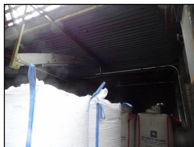
Figuur 14. Binnenzijde golfplatendak van gebouw 2.
