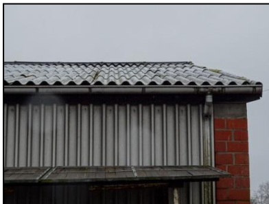
Figuur 6. Golfplaten dak van schuur.
