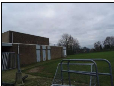
Figuur 6. Sporthal aan de noordoostzijde van de onderzoekslocatie.
