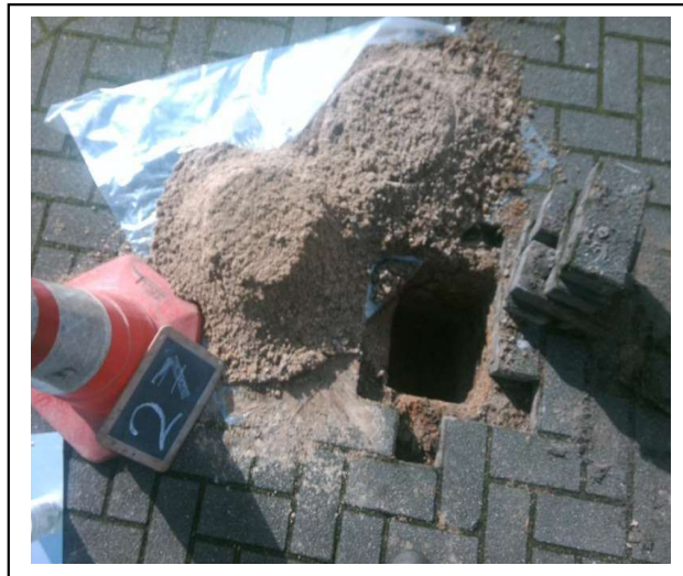
Foto 4. Asbestinspectiegat 27
