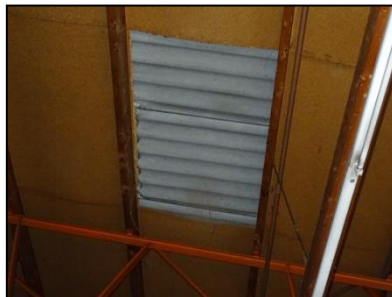
Figuur 7. Binnenzijde dak van schuur.
