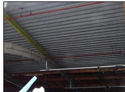
Figuur 8. Binnenzijde dak van opslaghal.
