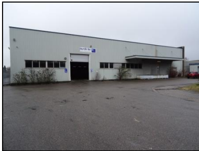
Figuur 3. Opslaghal op de onderzoekslocatie .
