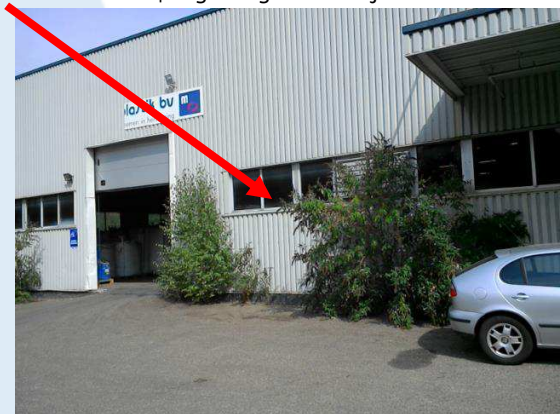
Foto 251 | Beglazingskit hal zij- en voorkant
