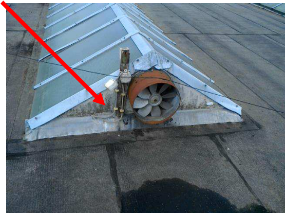
Foto 106 | Beplating kopgevels lichtkoepels
