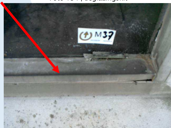
Foto 136 | Beglazingskit kozijnen kantoor
