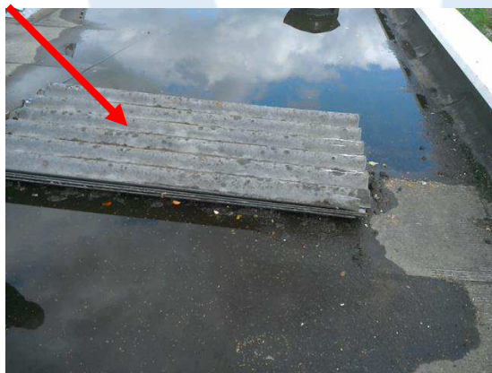
Foto 107 | Golfplaten op het dak
