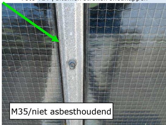
Foto 123 | Bitumen stroken shedkappen
