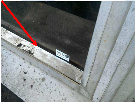
Foto 137 | Beglazingskit kozijnen kantoor
