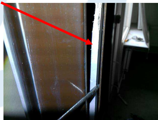
Foto 28 | Plaat in kluisdeur
