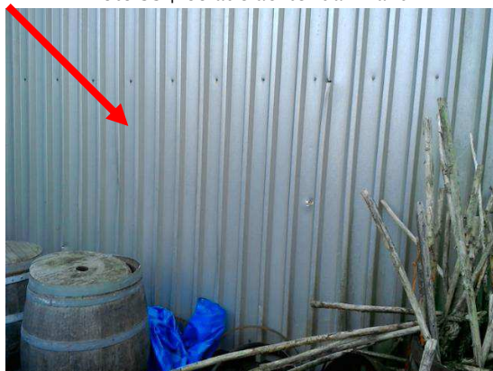
Foto 101 | Isolatie achter damwand
