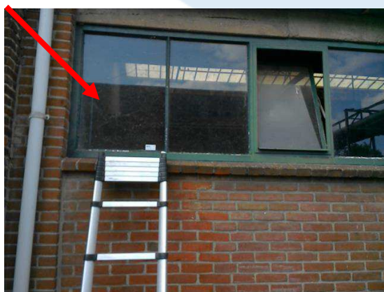
Foto 141 | Stopverf kozijnen
