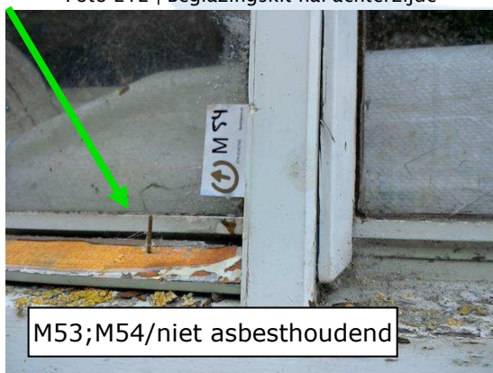
Foto 214 | Beglazingskit hal achterzijde
