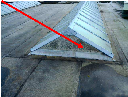
Foto 105 | Beplating kopgevels lichtkoepels
