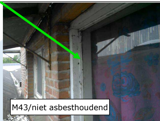
Foto 153 | Beglazingskit kantoor verdieping
