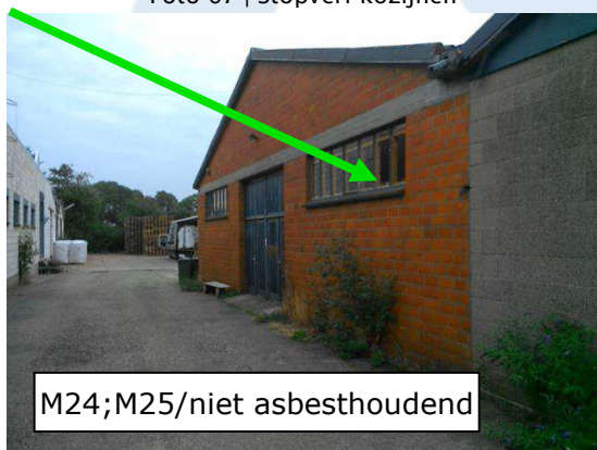
Foto 69 | Stopverf kozijnen
