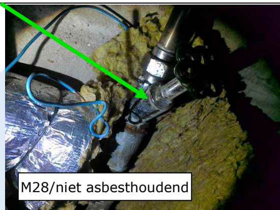
Foto 92 | Pakking brandslang haspel
