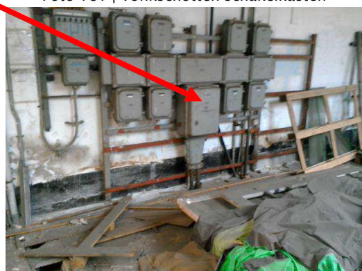
Foto 183 | Vonkschotten schakelkasten
