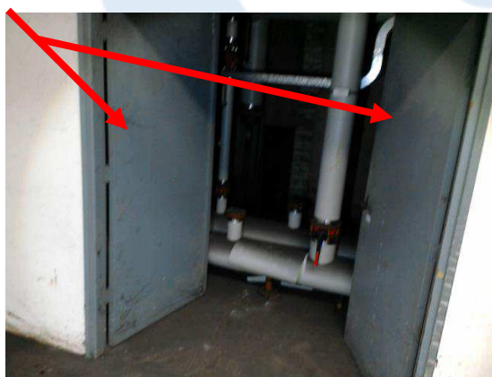
Foto 188 | Beplating op deuren technische ruimten
