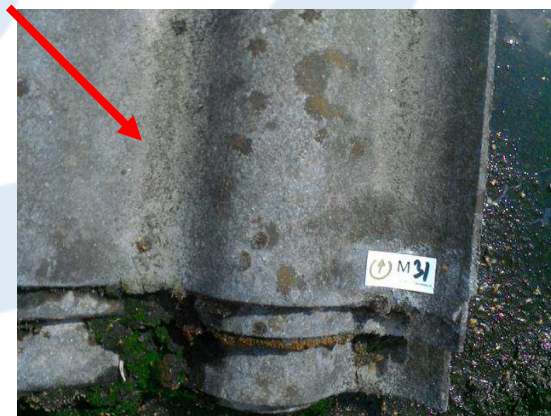
Foto 108 | Golfplaten op het dak
