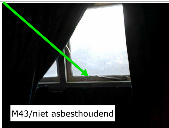
Foto 152 | Beglazingskit kantoor verdieping
