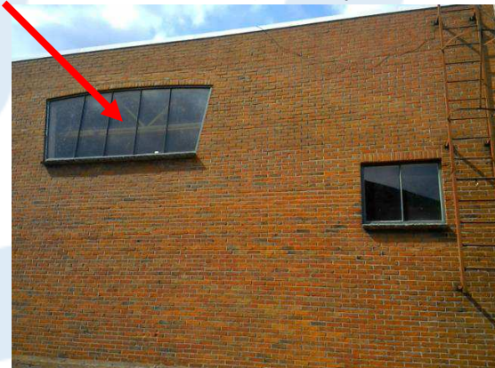
Foto 148 | Stopverf kozijnen
