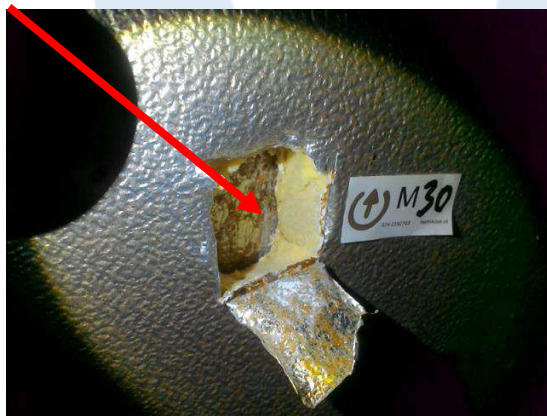
Foto 99 | Isolatie achter damwand
