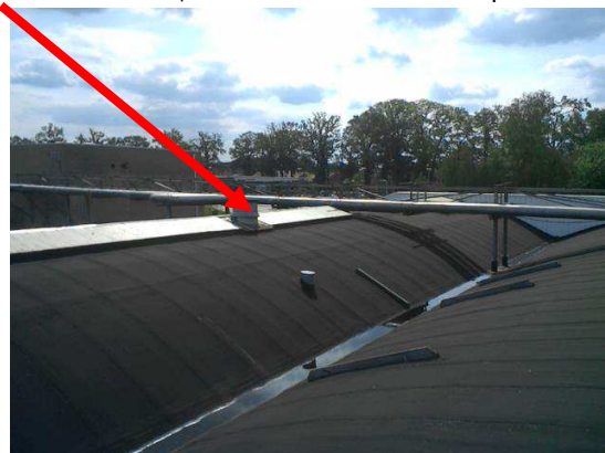
Foto 119 | Kitrand ventilatiekokers op dak
