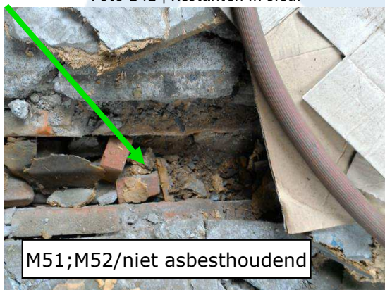
Foto 244 | Restanten in sleuf
