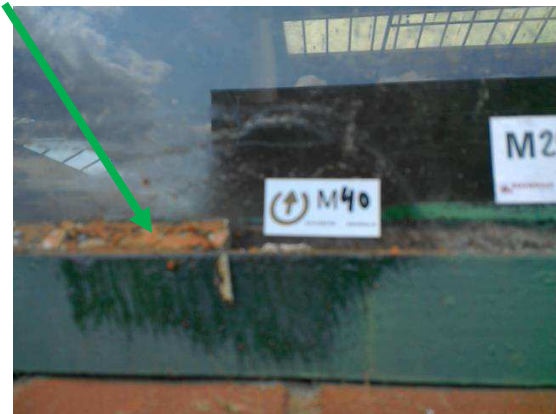
Foto 144 | Stopverf kozijnen
