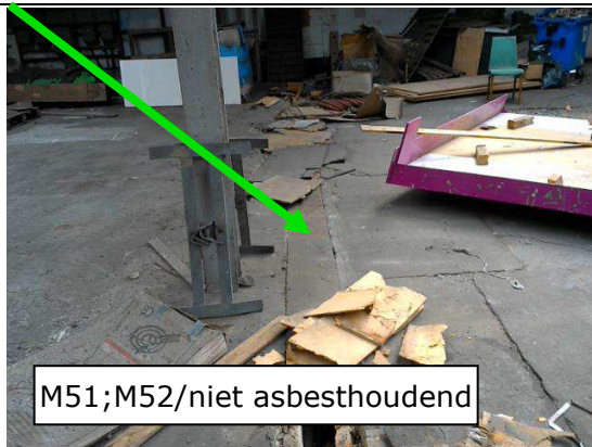
Foto 242 | Restanten in sleuf
