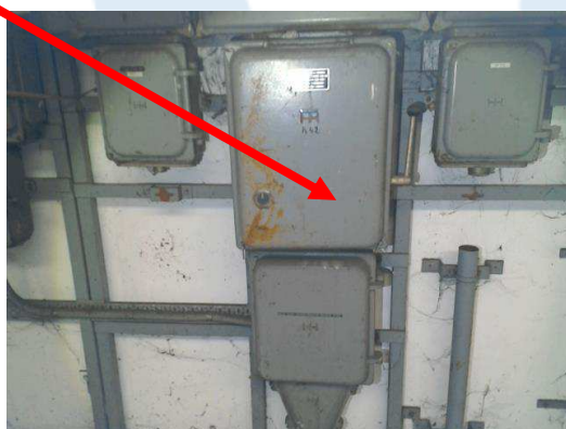
Foto 181 | Vonkschotten schakelkasten
