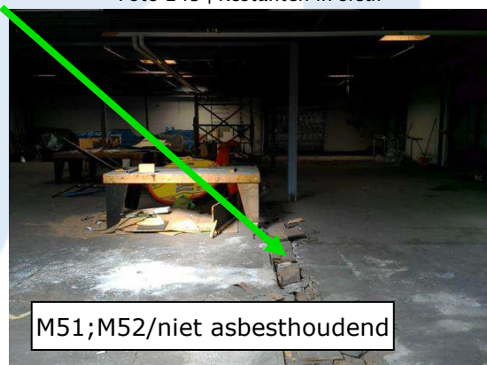
Foto 245 | Restanten in sleuf
