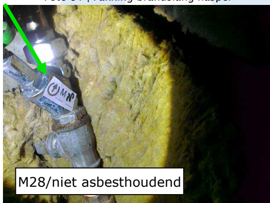
Foto 93 | Pakking brandslang haspel
