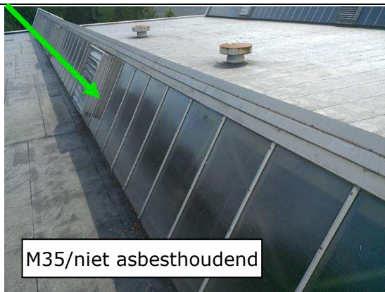
Foto 121 | Bitumen stroken shedkappen
