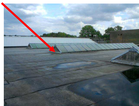
Foto 104 | Beplating kopgevels lichtkoepels
