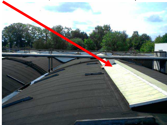
Foto 118 | Kitrand ventilatiekokers op dak
