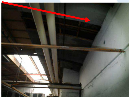
Foto 184 | Plafond technische ruimten
