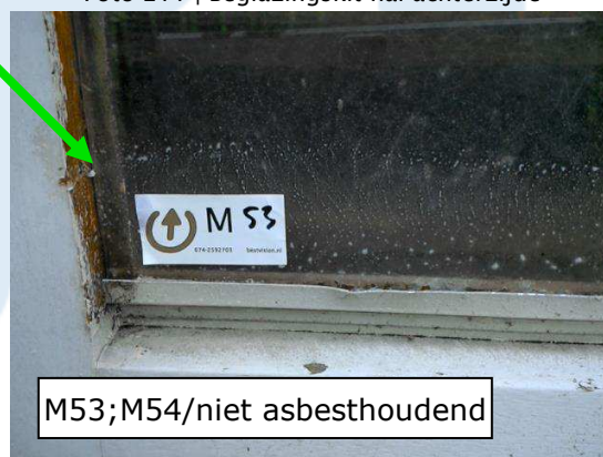
Foto 213 | Beglazingskit hal achterzijde
