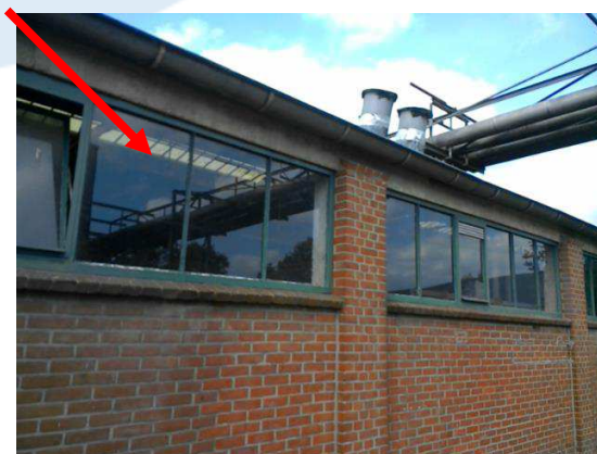
Foto 142 | Stopverf kozijnen
