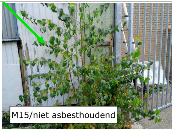
Foto 33 | Bitumenpapier in buitenwanden
