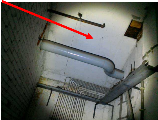
Foto 186 | Plafond technische ruimten
