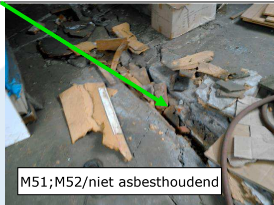
Foto 243 | Restanten in sleuf
