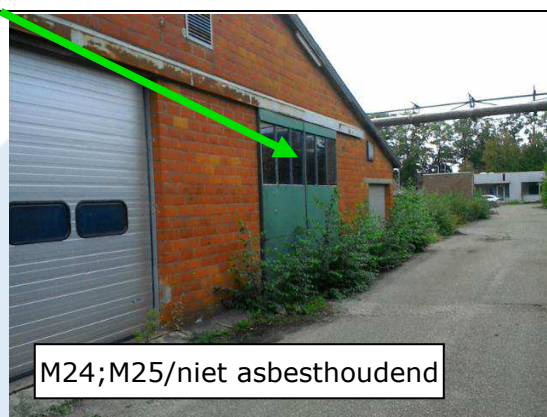
Foto 68 | Stopverf kozijnen
