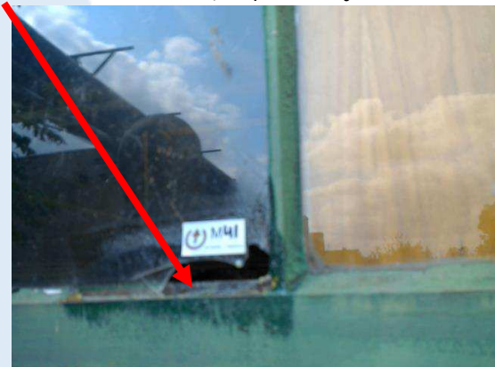
Foto 146 | Stopverf kozijnen
