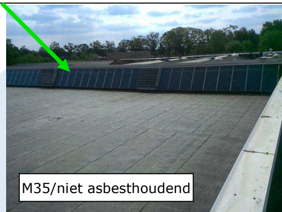
Foto 122 | Bitumen stroken shedkappen
