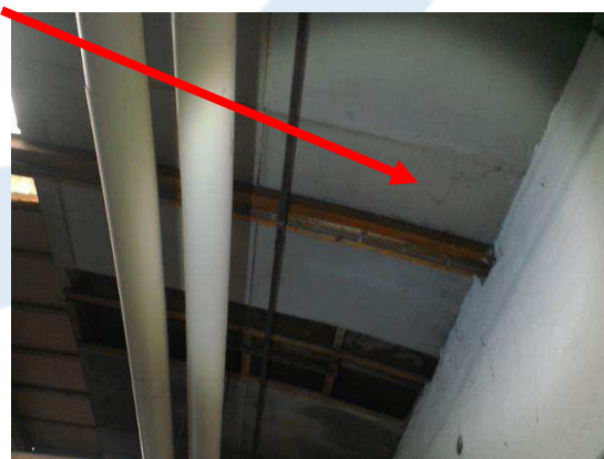
Foto 185 | Plafond technische ruimten
