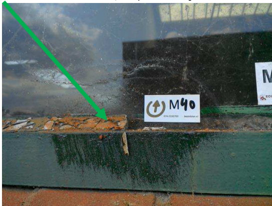
Foto 145 | Stopverf kozijnen
