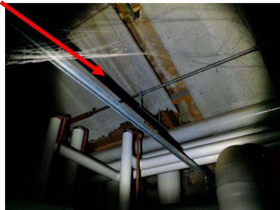
Foto 187 | Plafond technische ruimten
