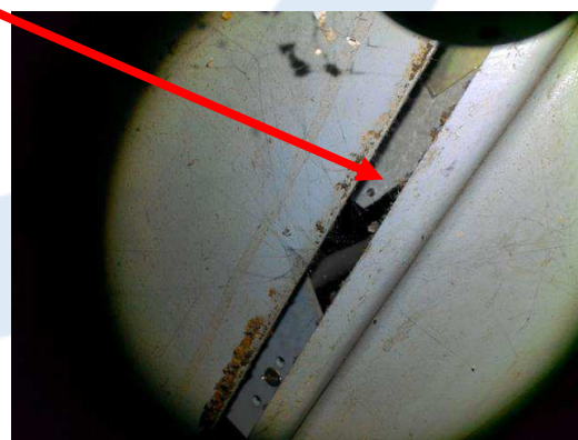
Foto 182 | Vonkschotten schakelkasten
