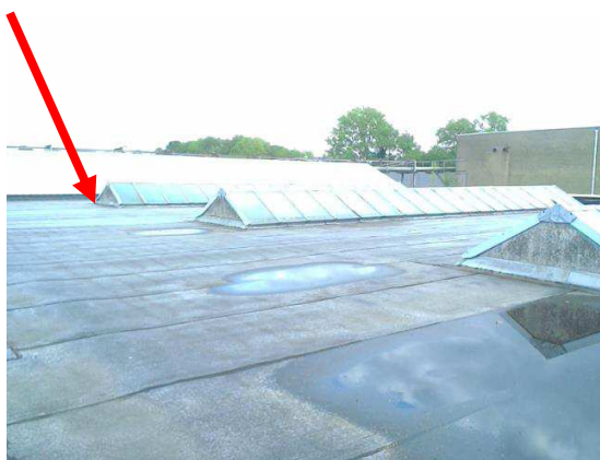
Foto 103 | Beplating kopgevels lichtkoepels
