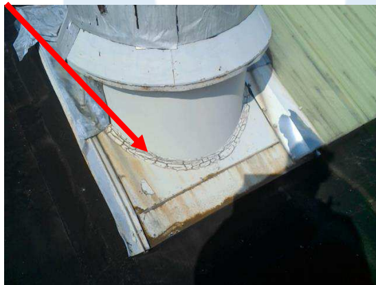
Foto 116 | Kitrand ventilatiekokers op dak
