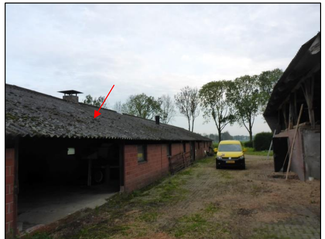
Foto 4: Schuur 1: Golfplaten dak inclusief nok (M01AA)
