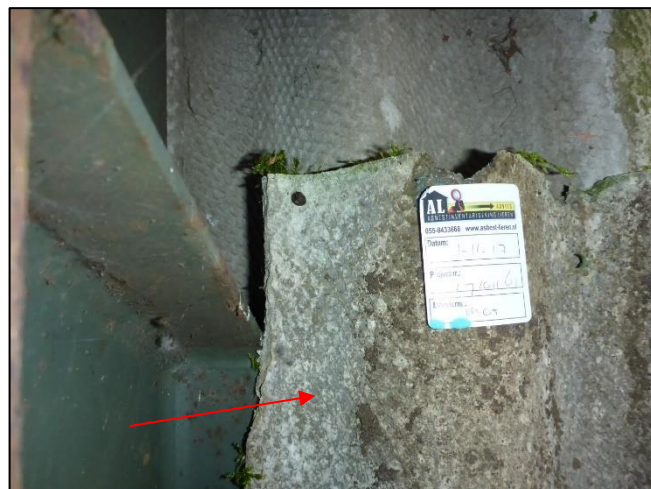
Foto 24: Gevel schuur 3: Golfplaat (M05AA)
