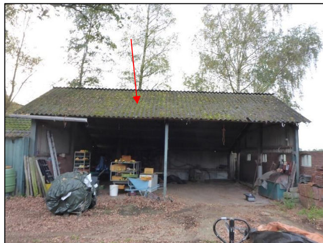
Foto 22: Schuur 3: Golfplaten dak (M05AZ)
