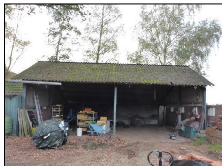
Schuur 3: Golfplaten dak (M05AZ)
