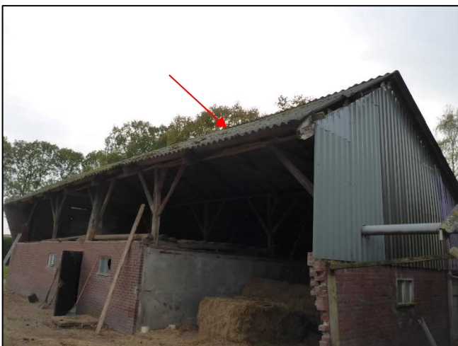
Foto 17: Schuur 2: Golfplaten dak (M04AA)
