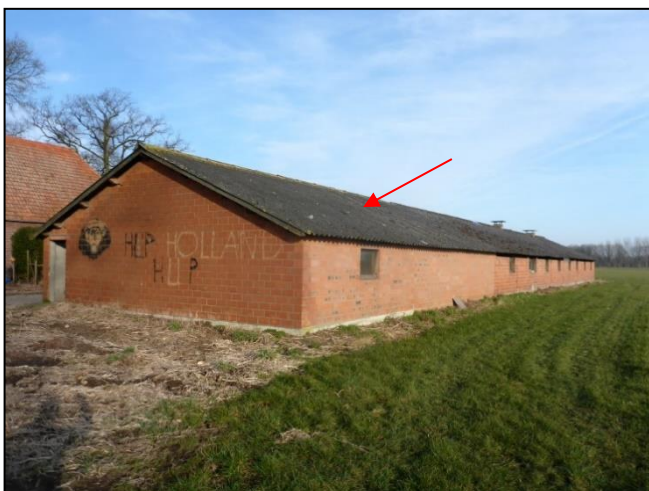
Foto 49: Schuur 1: Golfplaten dak incl. nok (M01AA)
