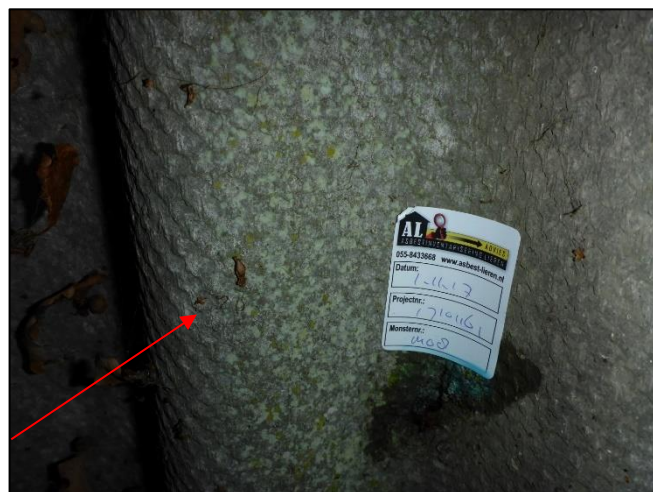
Foto 34: Gevel schuur 4: Golfplaat (M08AA)
