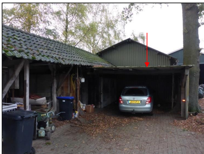
Foto 33: Schuur 4: Golfplaten dak (M08AZ)
