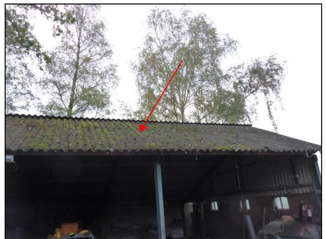
Foto 30: Schuur 3: Golfplaten dak (M05AZ)
