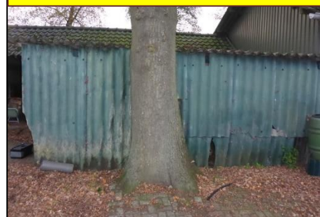
Gevel schuur 4: Golfplaat (M08AA)
