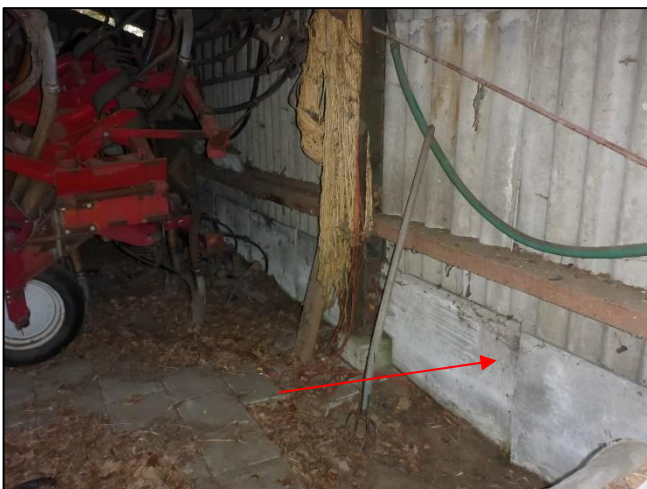
Foto 29: Gevel schuur 3: Vlakke plaat (M06AA)
