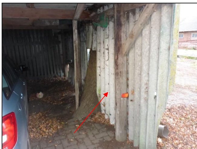
Foto 35: Gevel schuur 4: Golfplaat (M08AA)
