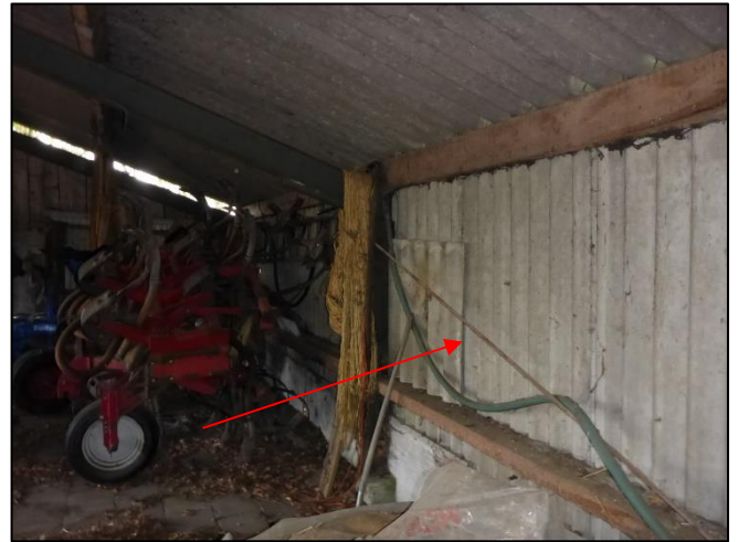
Foto 26: Gevel schuur 3: Golfplaat (M05AA)
