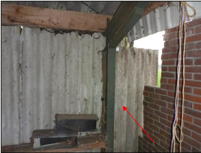
Foto 25: Gevel schuur 3: Golfplaat (M05AA)
