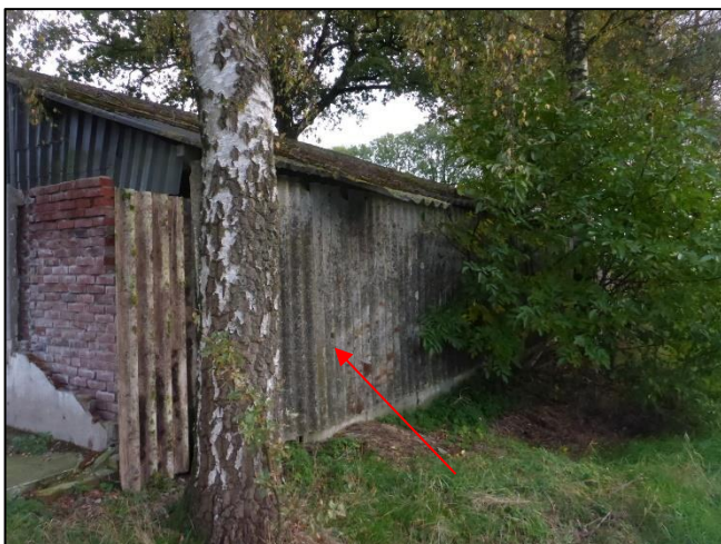
Foto 23: Gevel schuur 3: Golfplaat (M05AA)
