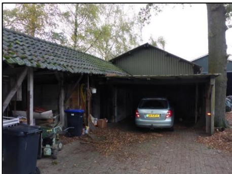
Schuur 4: Golfplaten dak (M08AZ)
