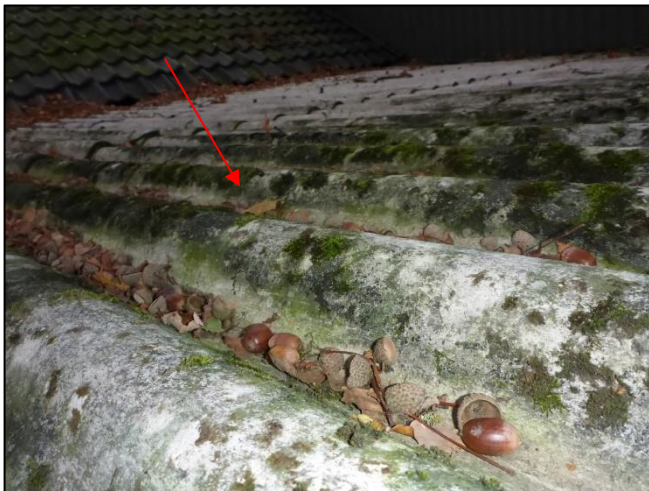
Foto 37: Schuur 4: Golfplaten dak (M08AZ)
