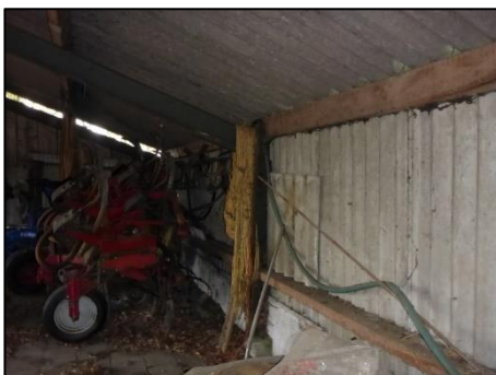
Gevel schuur 3: Golfplaat (M05AA) & Vlakke plaat (M06AA)
