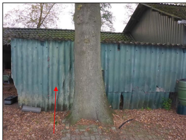
Foto 36: Gevel schuur 4: Golfplaat (M08AA)
