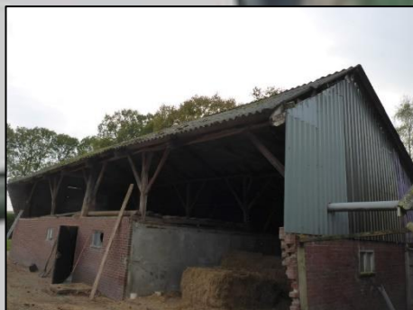
Schuur 2: Golfplaten dak (M04AA)
