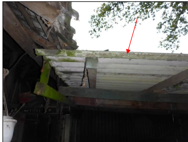
Foto 38: Schuur 4: Golfplaten dak (M08AZ)
