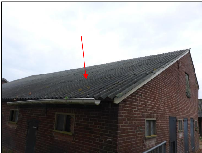
Foto 19: Schuur 2: Golfplaten dak (M04AA)
