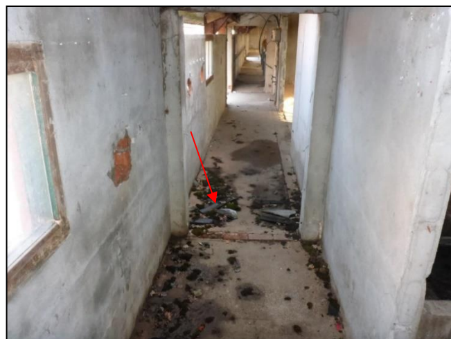
Foto 48: In schuur 1: Restanten golfplaten (M01AZ)
