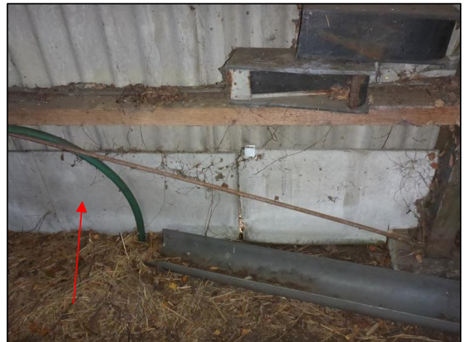
Foto 28: Gevel schuur 3: Vlakke plaat (M06AA)
