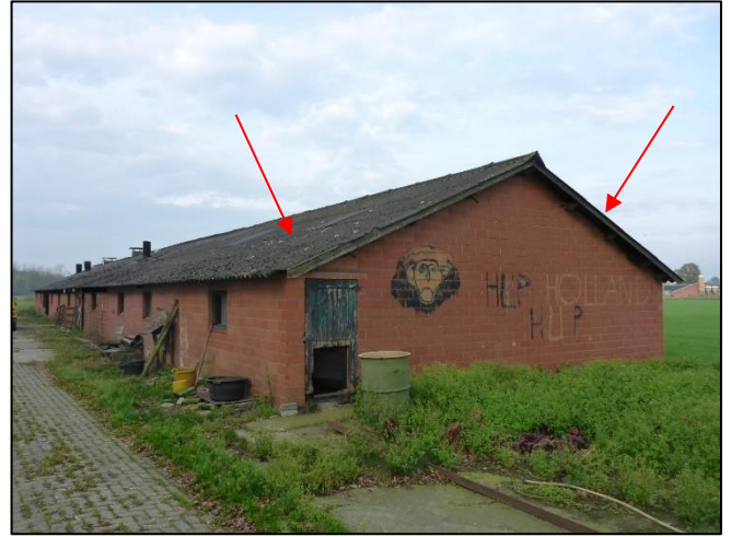
Foto 2: Schuur 1: Golfplaten dak inclusief nok (M01AA)
