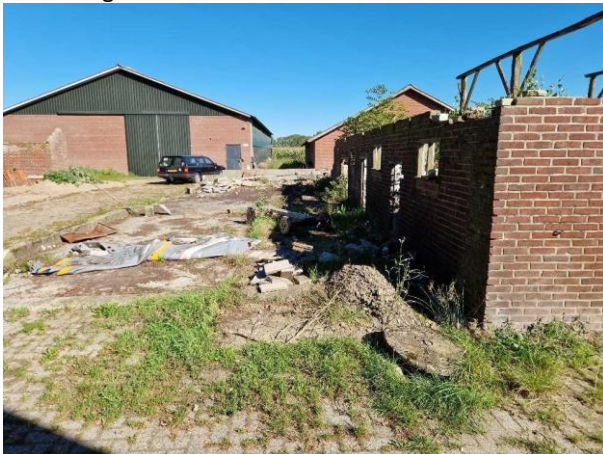
Figuur 11: Verharde druppelzone (zuidelijke schuur)
