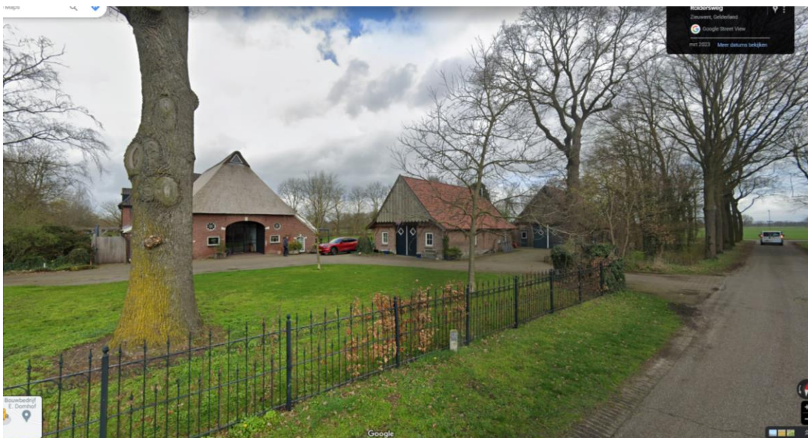
Zicht op de entree van het erf, vanaf de Roldersweg.
