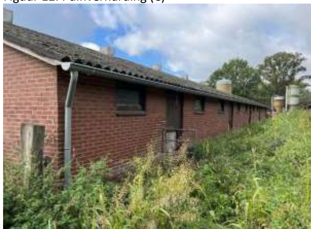
Figuur 14: Dakgoot bebouwing
