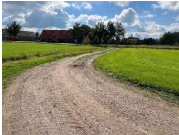
Figuur 12: Puinverharding (C)
