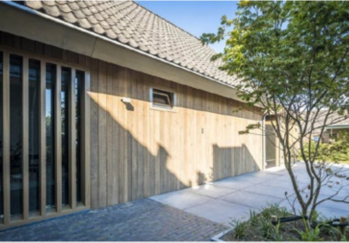
Gesloten gevel erfzijde
