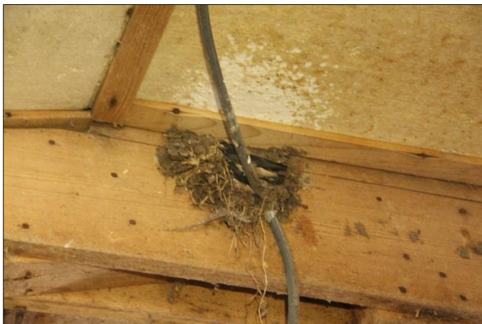
Boerenwaluwnest in de te slopen veestal.
